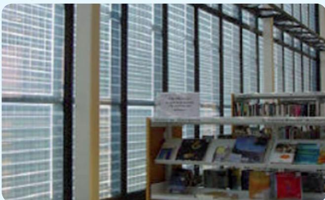
La biblioteca Pompeu Fabra de Mataró fue diseñada con una doble finalidad, la generación de energía FV y energía térmica, además de asegurar el máximo confort. La instalación consiste en un muro cortina basado en células solares de silicio policristalino, de manera que se asegura la luz natural en el interior de la biblioteca.
